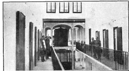
Una de las galerías principales de la nueva Cárcel. Al fondo, el patio central y la capilla
