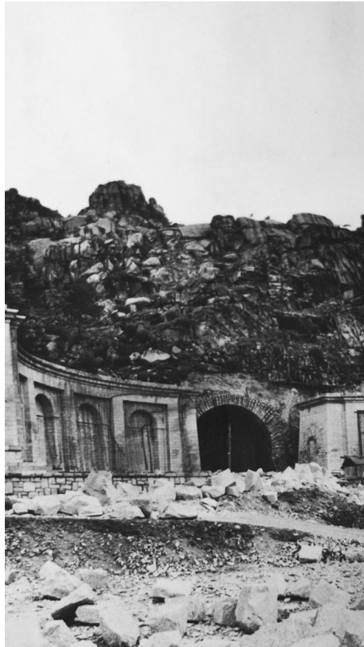
Valle de los Caídos durante su construcción
