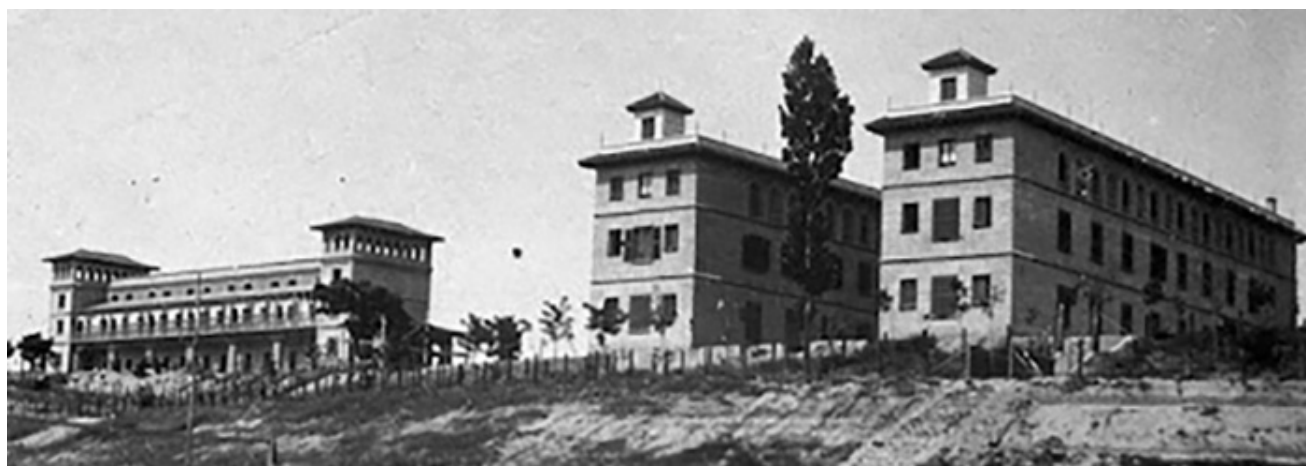
Edificio de la Junta de Ampliación de Estudios.
